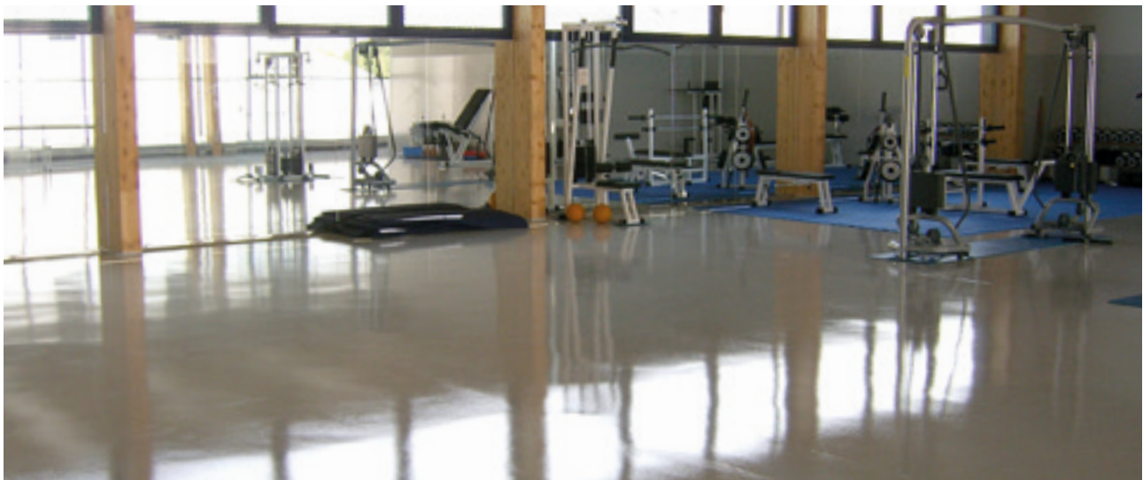
Pavimento autonivelante en un gimnasio. Italia.
