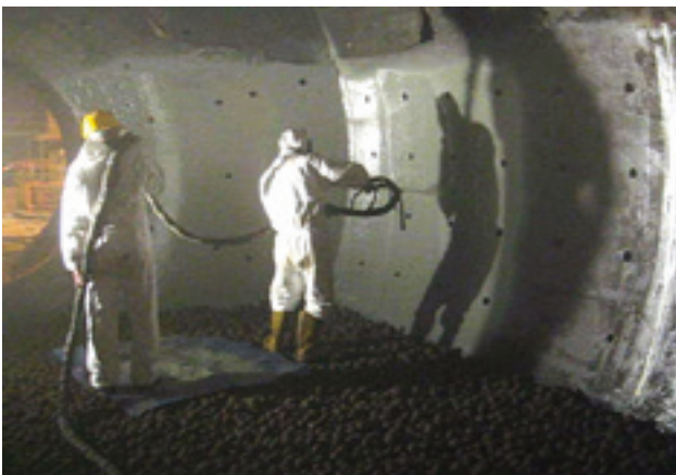
Revestimiento de un molino de bolas.
